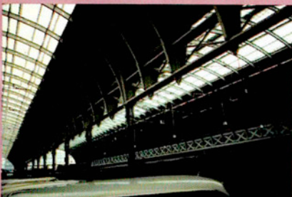
Les noves tècniques de construcció amb ferro i vidre de final del segle passat i principi d'aquest, donen noves possibilitats a aquests edificis, especialment a les grans estacions terminals. Estació de Paddington, Londres, 1854.
