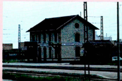
Quan el transport de viatgers es va fer més intensiu, apareix l'edifici de l'estació, quasi sempre construït segons un model establert en un catàleg de solucions tipològiques. Estació de Camarles.
